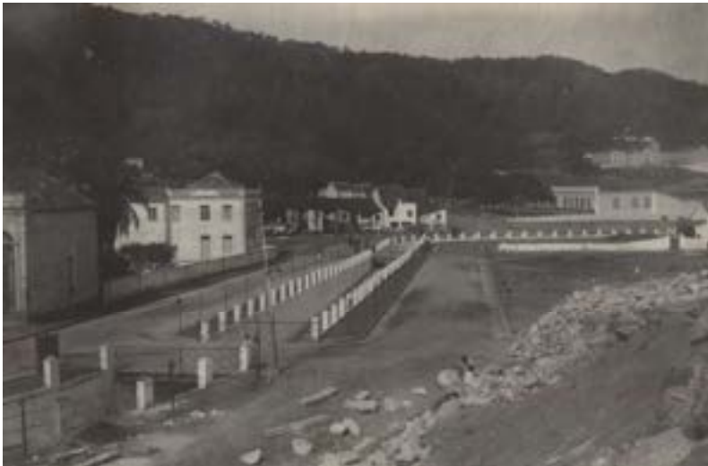
Fonte Grande, 1922. Avenida do Saneamento em obras, já com as duas alamedas construídas sobre áreas de cortiços demolidos. À direita a retirada de rochas da antiga Pedreira. Acervo do Instituto Histórico e Geográfico de Santa Catarina.
