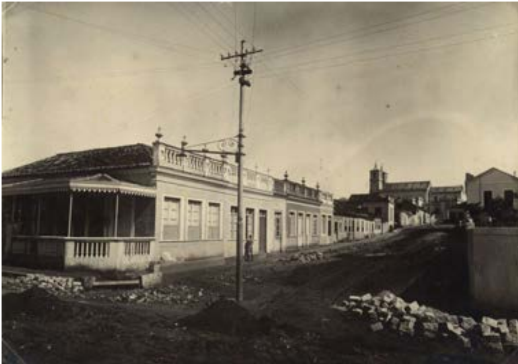
Casas térreas na Rua do Desterro, início da década de 1920. A rua sendo calçada com paralelepípidos de granito. Em primeiro plano, amplas casas térreas com platibanda, seguidas por casinhas de porta e janela sem platibanda. Acervo do Instituto Histórico e Geográfico de Santa Catarina.
