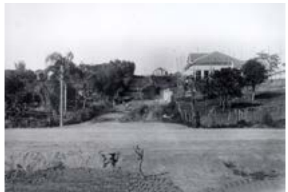
Figura 54 - Abertura Rua Felipe Schmidt, 1932. Rua da Vila dos Engenheiros. Fonte: Arquivo Histórico Municipal.
