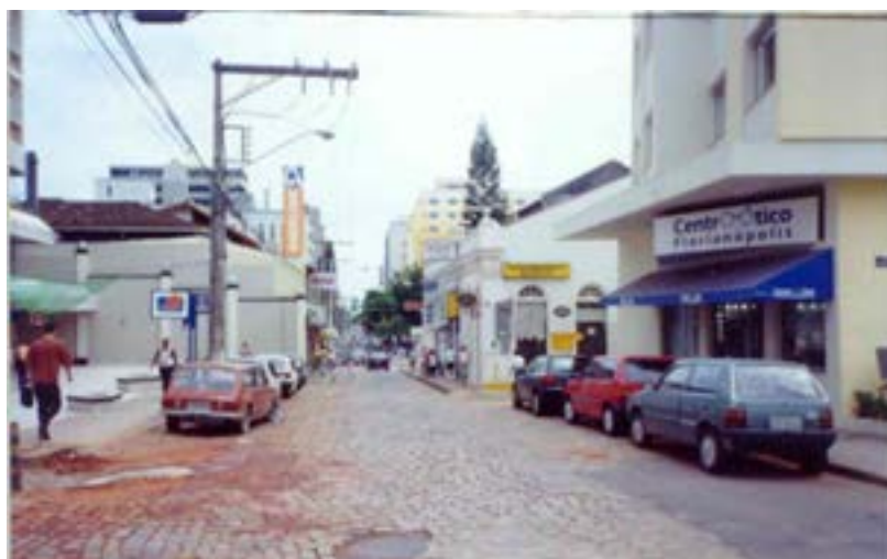
Figura 7 – Mau estado da pavimentação, evidenciando inclusive enxertos de asfalto. Foto tomada pela autora.
