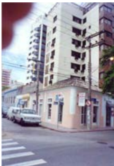
Figura 5 – Conjunto Rua do Passeio tombado. Prédios elevados e colados ao conjunto prejudicam sua paisagem, contrariando a Lei do Tombamento. Foto tomada pela autora.
