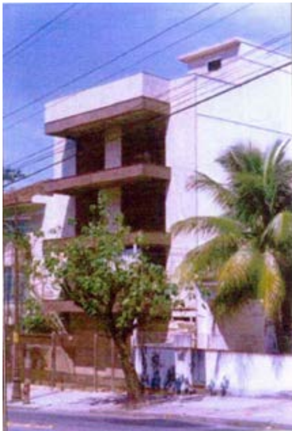
Construções de acordo com o novo gabarito.
