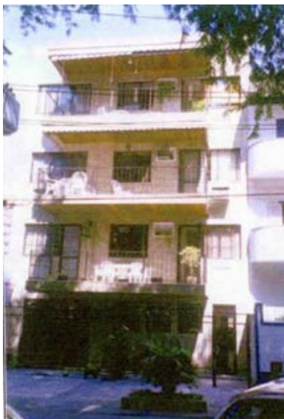
Construções de acordo com o novo gabarito.
