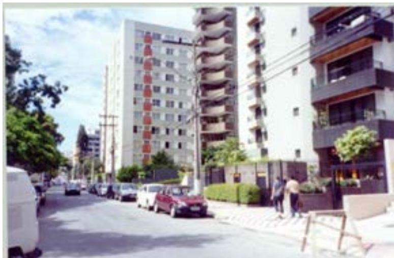
Figura 3 – Alargamento da rua e intensa verticalização. Foto tomada pela autora.
