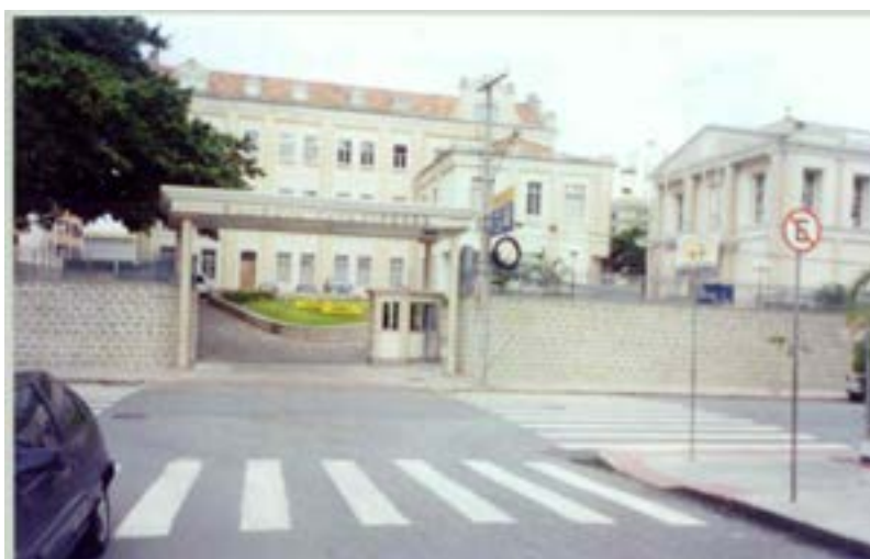
Colégio Catarinense. Prédio parcialmente tombado. Muro de arrimo demonstra rebaixamento do primitivo nível do leito da rua. Foto tomada pela autora.
