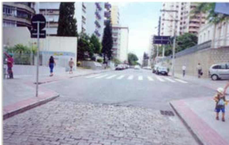
Figura 1 - Alargamento da rua para construção de prédios residenciais de apartamentos. Foto tomada pela autora.
