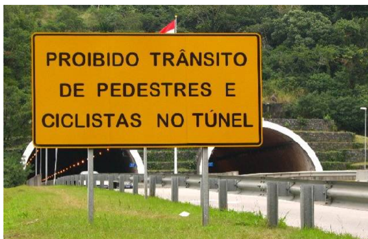
Figura 23: Entrada do túnel Antonieta de Barros Foto da autora
